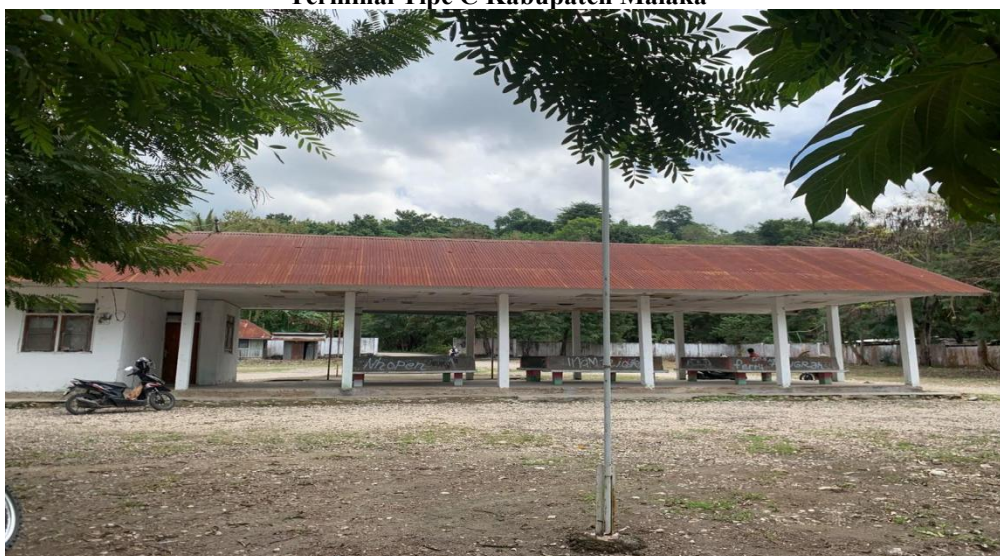
Gambar 4.2 Terminal Tipe C Kabupaten Malaka
