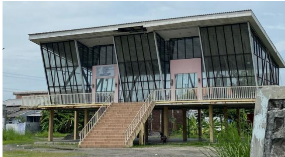
Gambar 1. Gedung Sentra Pia Kejapanan
