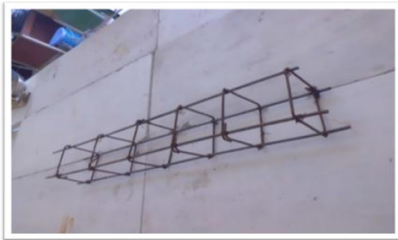
Gambar 4. Tulangan dengan sengkang rectangular untuk kolom berongga 20/20
